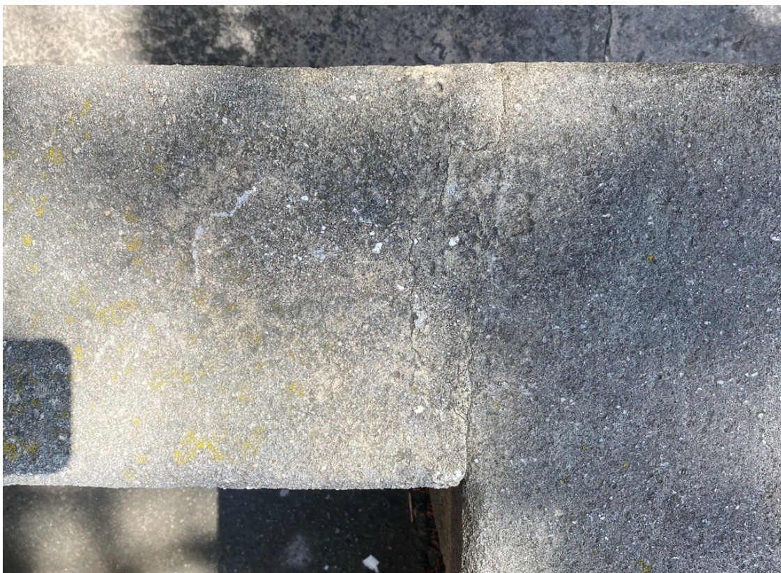
Madlo balustrády: biocidní napadení, praskliny, znečištění
