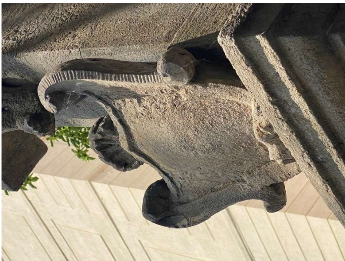
Nápisová kartuše: dožilé tmelení, sprašování materiálu, tvorba tmavých krust
