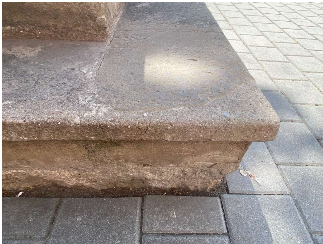
Sokl, stupeň: praskliny, dožilé tmelení a spárování, praskliny, degradace základu následkem působení vlhkosti
