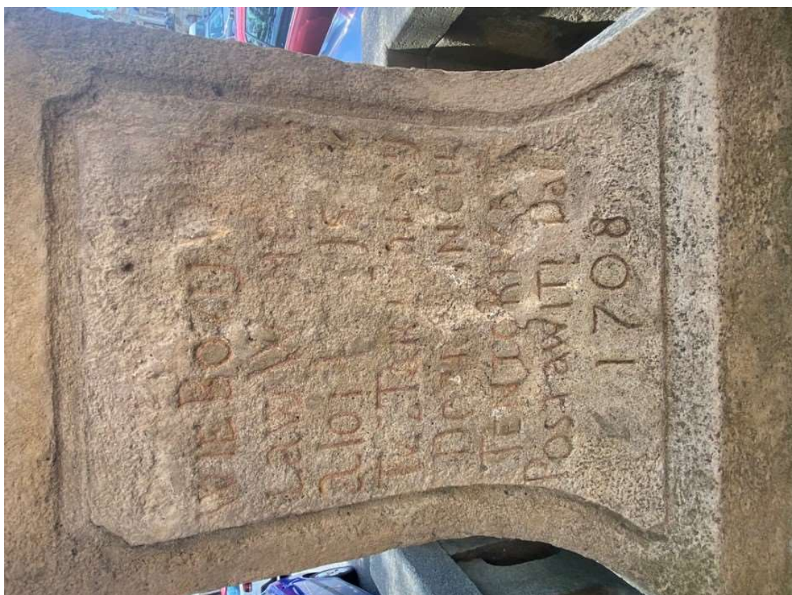
Nápis na soklu: Dochované torzo nápisu, sprašování a degradace kamene, lokální
