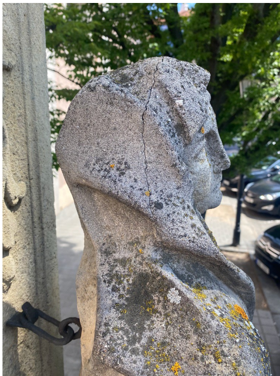
Domodelovaná hlava Panny Marie – nevhodná struktura, zásadní prasklina napříč hlavou, silné biocidní napadení
