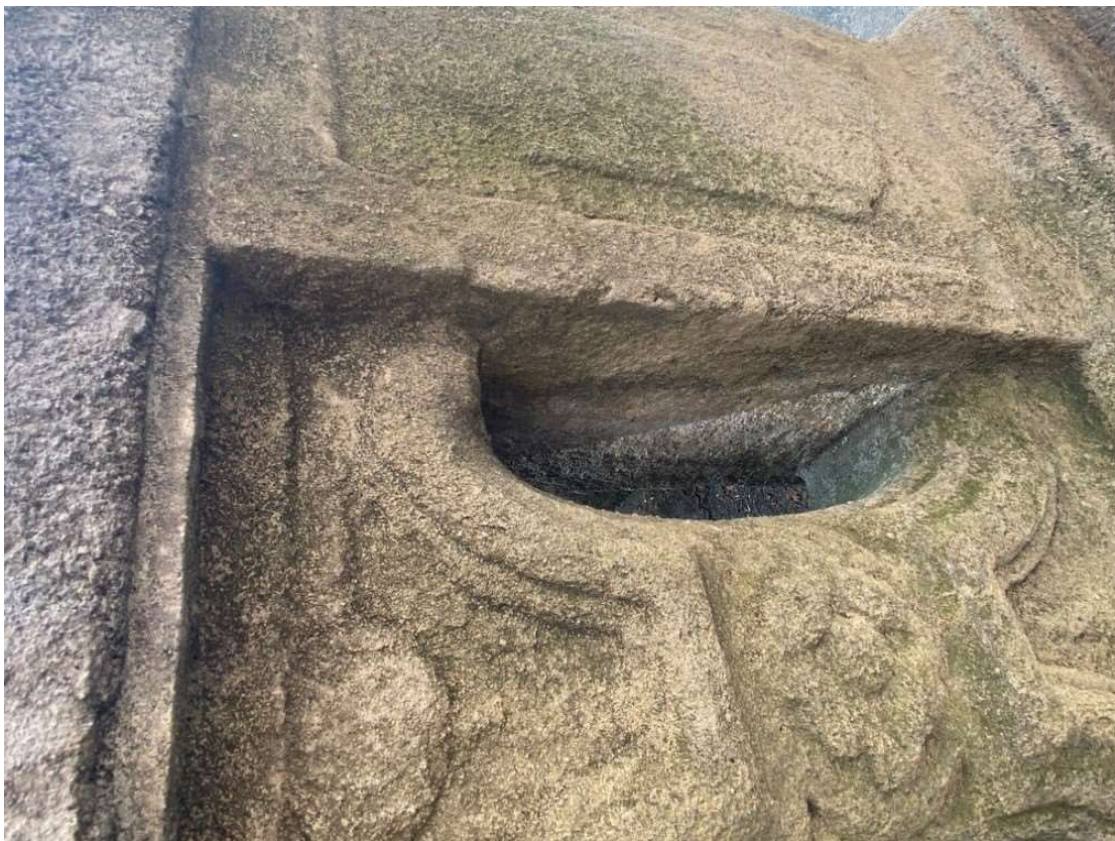
Balustráda: znečištění, biocidní napadení, eroze kamene, ztráta modelace, tvorba krust
