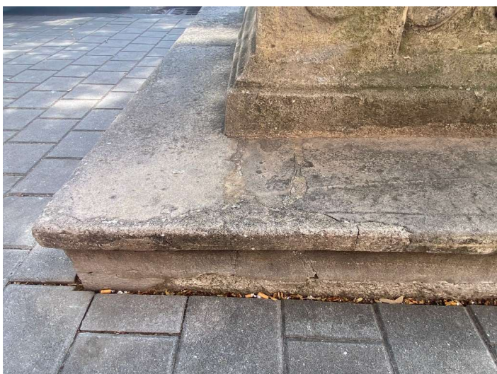
Viditelné trhliny a staré dožilé nevyhovující doplňky
