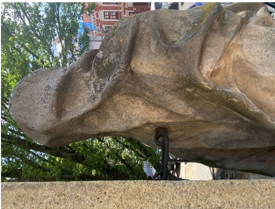
Kovové prvky: ukotvení sochy, koroze materiálu v místech styku s pískovcem
