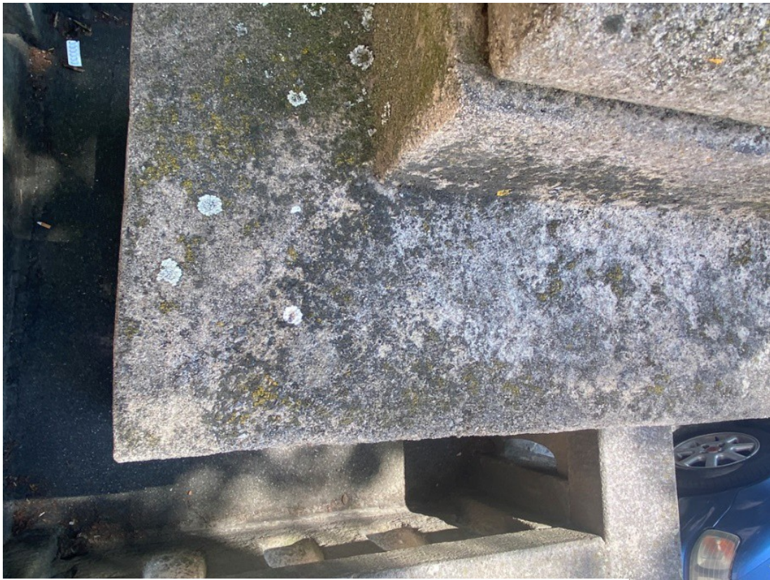
Sokl: sprašování kamene, biocidní napadení (líšejníky, mechy, tvorba krust
