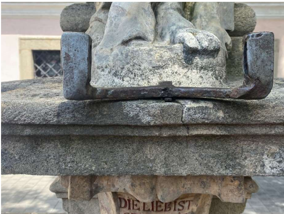
Sokl pod sochou PM: prasklina pod kovovým prvkem, dožilé tmely tvorba krust
