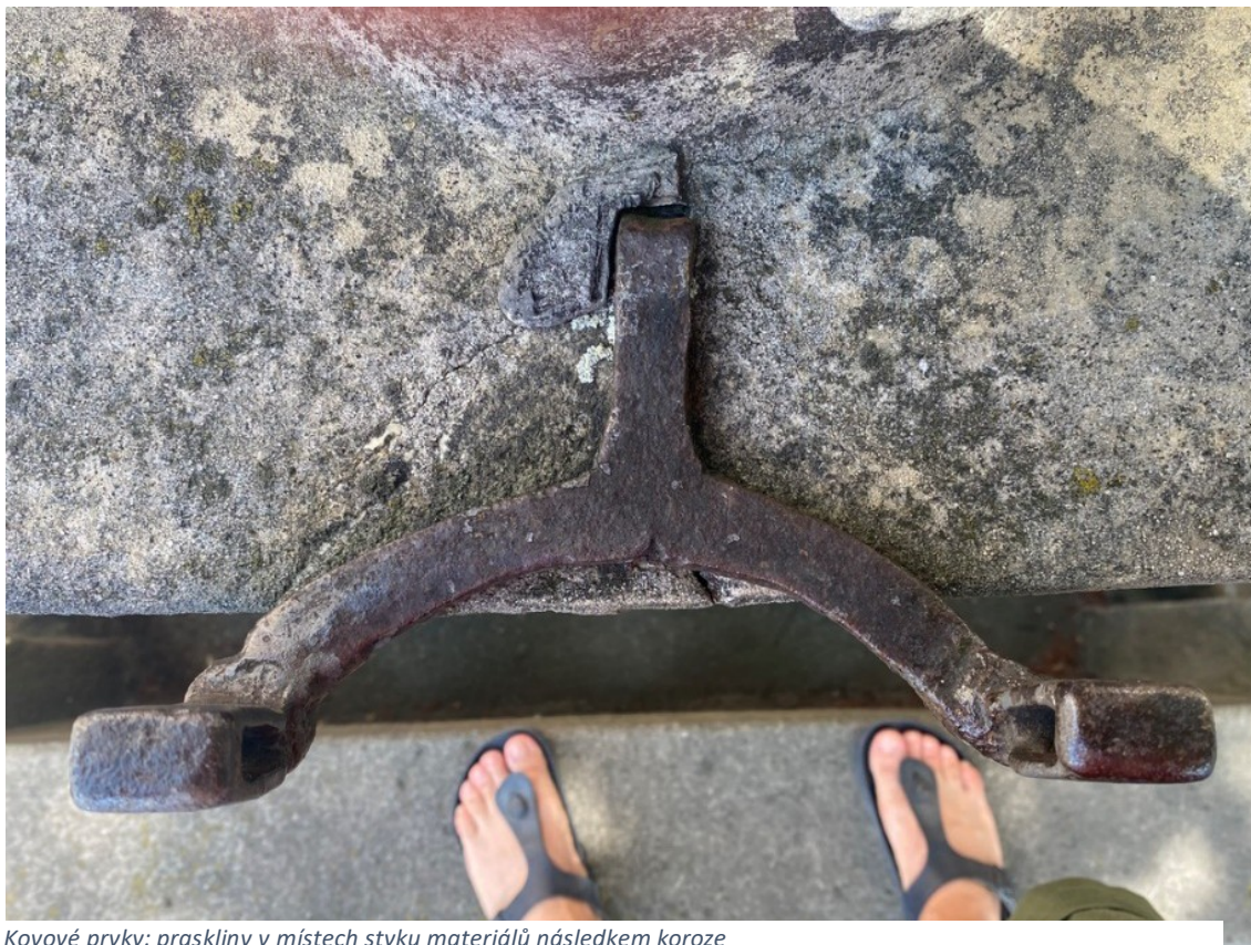
Kovové prvky: ukotvení sochy, koroze materiálu v místech styku s pískovcem
