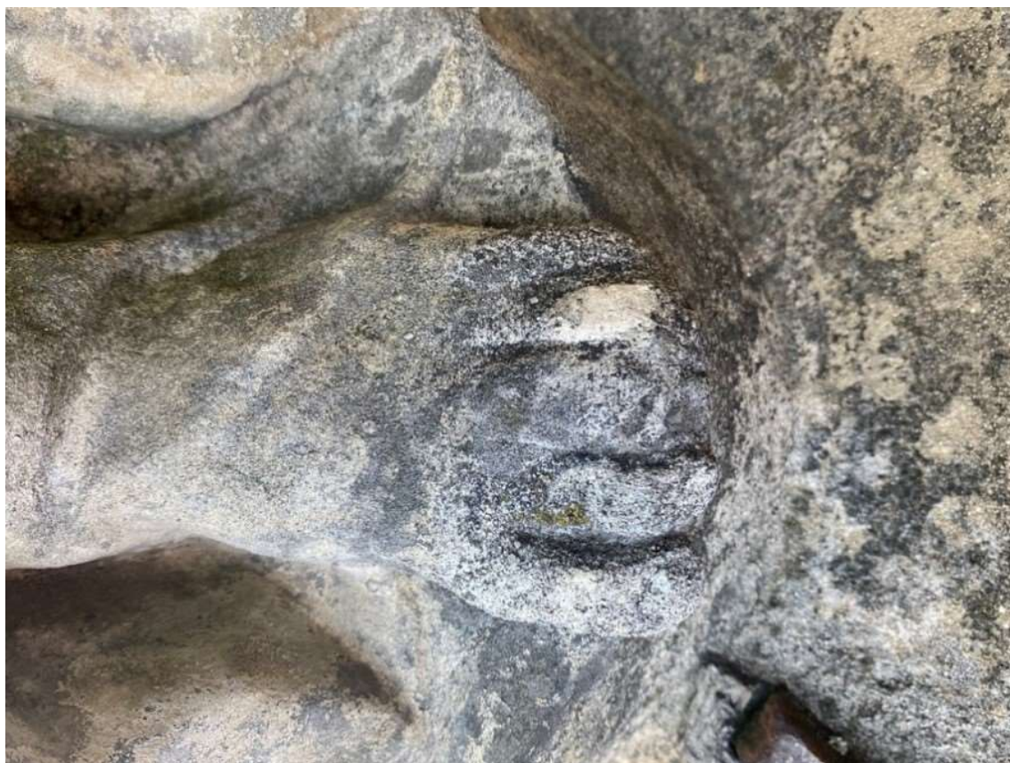
Socha Panny Marie – nevhodný doplněk, úbytek hmoty v oblasti nohou, biocidní napadení, krusta
