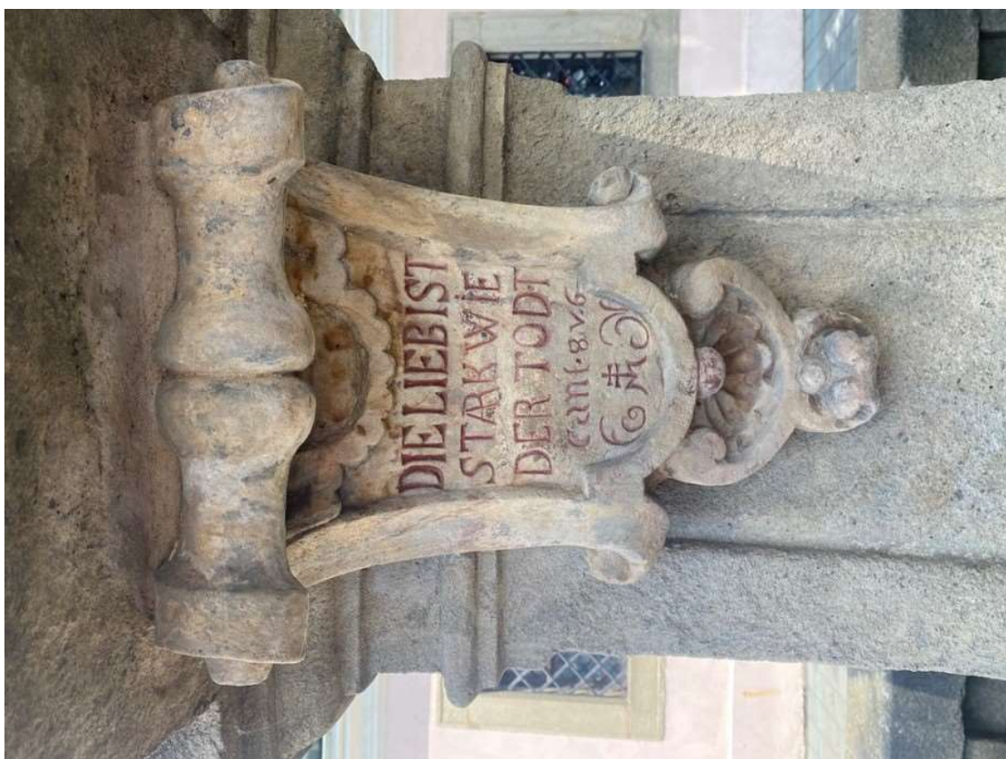
Nápis na soklu: Dochované torzo nápisu, sprašování a degradace kamene, lokální
