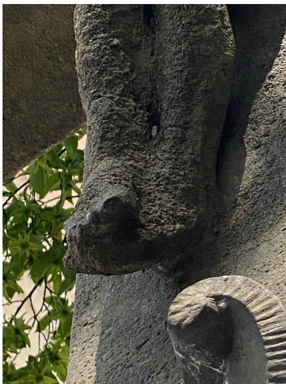
Koroze kamene – úbytek originální hmoty, ztráta modelace – vyplavování měkčích částí kamene, domodelované nohy Krista z předešlého restaurování
