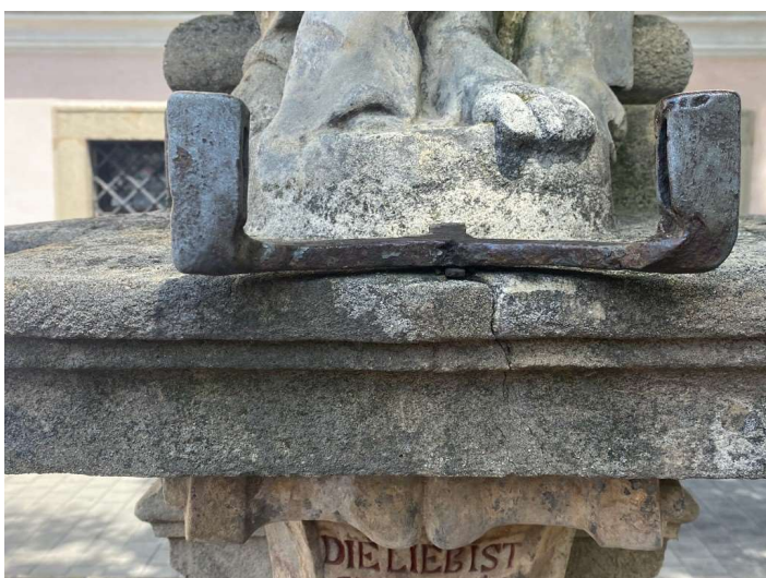
viditelná trhlina od korodujícího uchycení pod sochou Panny Marie
