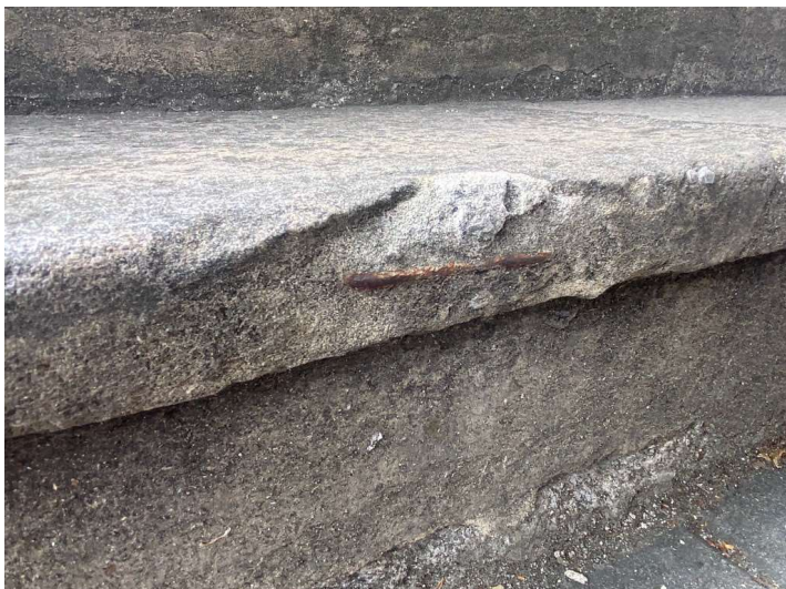
Nevhodná korodující armatura
